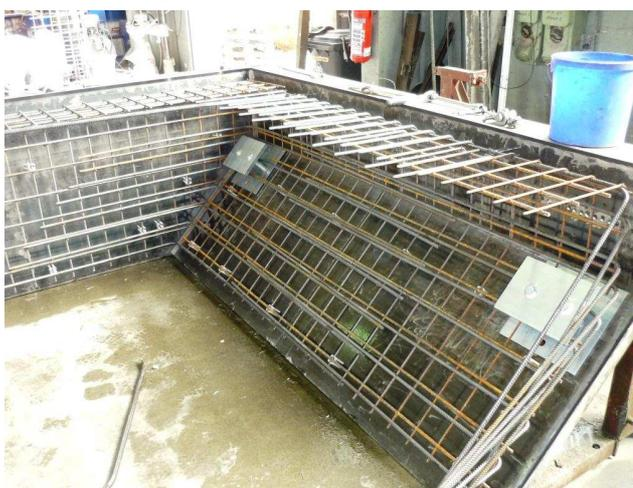
Es wird sehr viel Eisengeflecht in die Form gebracht. An dem Geflecht sind die Halterungen für Verbindungen, Poller, Scheuerleisten und andere Bauteile verschweißt.
