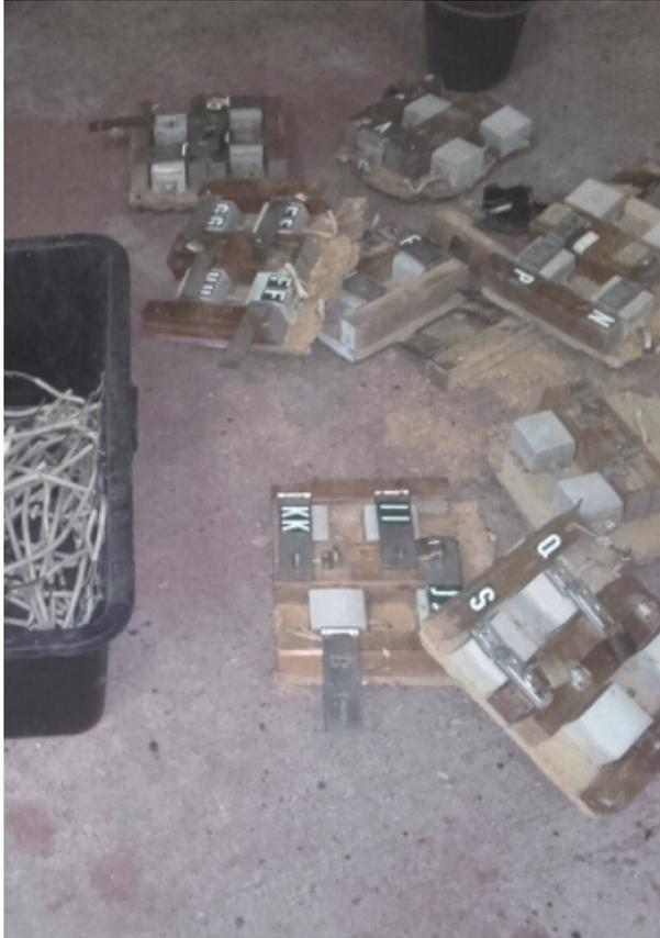
Als nächstes wurden die neuen Verteilerkästen (je vier Zähler mit Steckdosen) an den alten Stellen auf neuen, von Jan Werber gebauten Platten angebaut sowie ein Kabelstrang erneuert.
