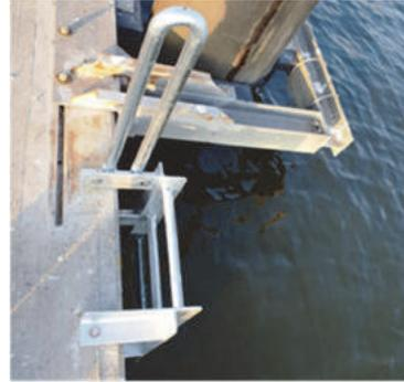
Eine zweite wird an der Verbindungsstelle der Schlegel montiert werden, und die dritte ist ähnlich wie im Hamburger Yachthafen eine mobile Leiter, die von einem Helfer an jeder beliebigen Stelle des Schlegels zum Einsatz gebracht werden kann. Sie hat ihren Platz am Mittelpfahl bei dem Rettungsring und wird bei Bedarf in die Holzscheuerleiste des Schlegels eingehakt.
